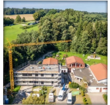
Neubau Kindergarten in Reute
